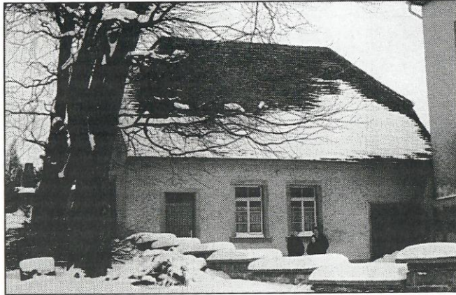
Der alte Betsaal vor dem Abbruch 1969.
